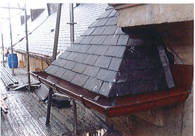
Gouttière pendante 1/2 ronde cuivre.
