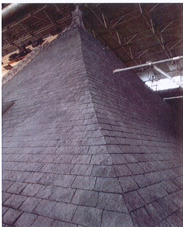
Arêtier fermé en ardoise naturelle.
