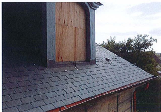
Appui plomb devant de lucarne.
