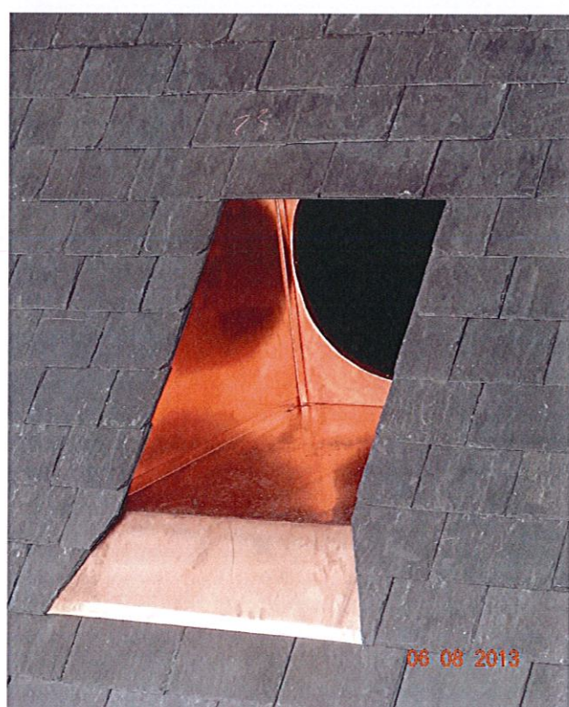
Sortie de ventilation.
